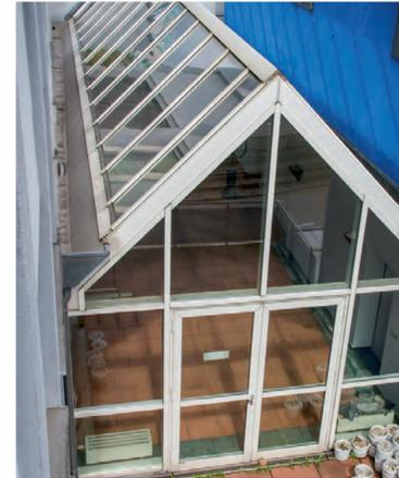
Links: Dachkonstruktion mit RWA-Lamellenfenstern. Olymp, Baujahr 2003
