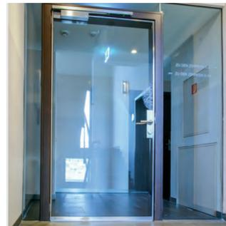
Links Tür: Sonderelement Hoba als T 30 Türe mit integriertem Rauchmelder
